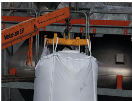
Materialul este transportat din big bag la containerul de preîncărcare la nivelul solului cu un stivuitor
